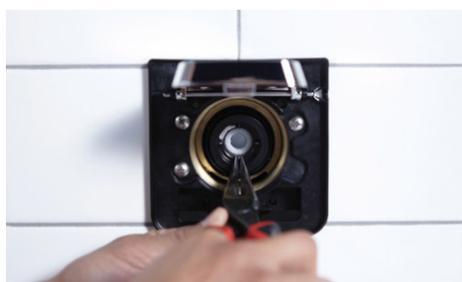
Diseñado con la menor cantidad de piezas posibles, hace que su mantenimiento sea sencillo. Se accede a las piezas a través de la placa de pared para minimizar la posibilidad de fugas.
