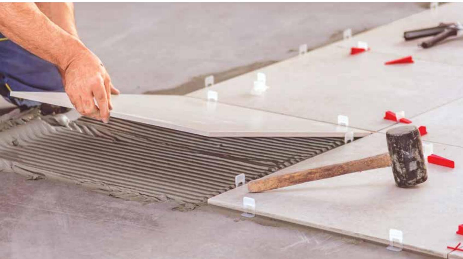
Con el Sistema de Nivelación Castel los pisos quedan perfectamente alineados y nivelados por la parte superior, lo que evita tener tropiezos a diferencia de la instalación tradicional.
